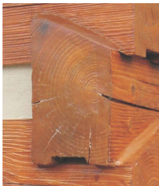
Полностью высохший Log End Seal
