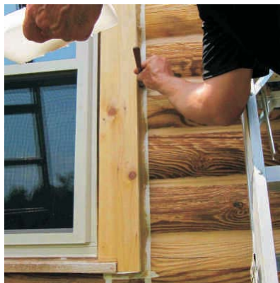
Равномерно распределите герметик по всей длине стыка. Затем аккуратно разгладьте герметик, периодически смачивая его водой
