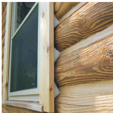
Установите материал в пустоты между брусом и рамой. Оставьте зазор размером 0,9 мм между поверхностью подкладочного материала и поверхностью рамы
