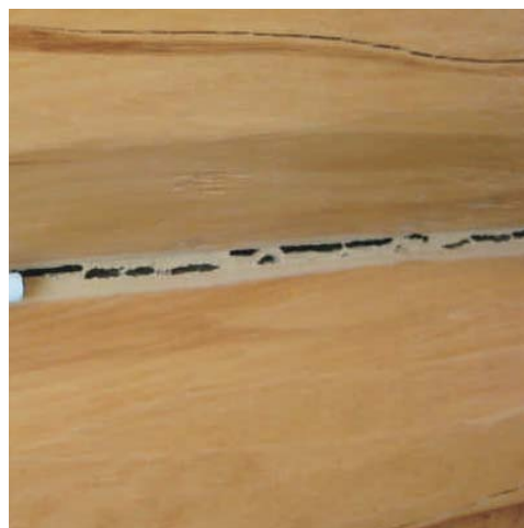
Последствие герметизации стыка без использования подкладочного материала
