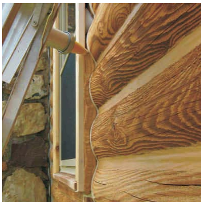
Заполните герметиком зазор между поверхностью подкладочного материала и поверхностью рамы
