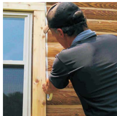
Для предотвращения загрязнения смежных бревен используйте изоляционную ленту
